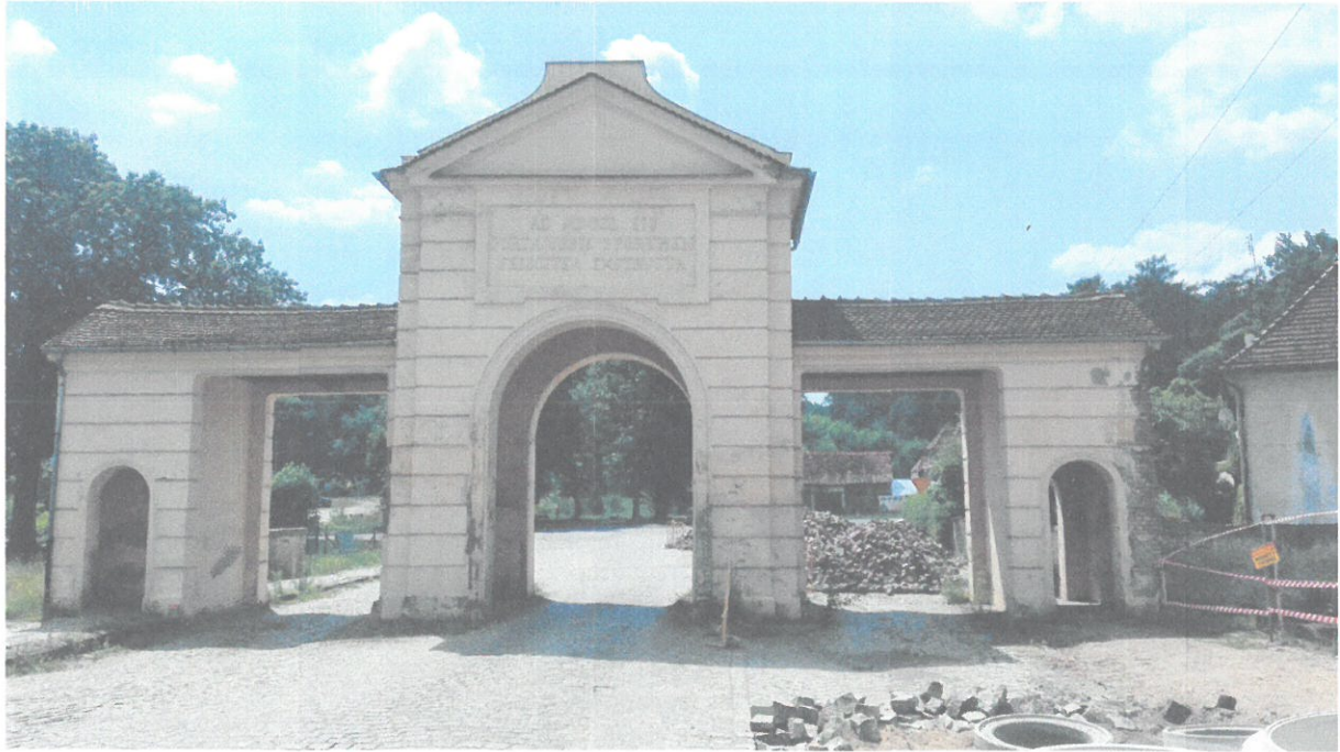
Fot. 1 Widok elewacji północnej
