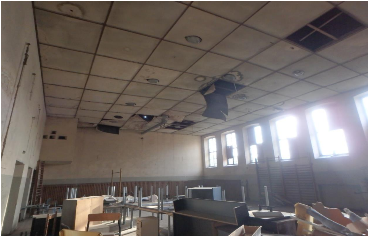
Zdjęcie nr 47 - Pomieszczenie na piętrze budynku
