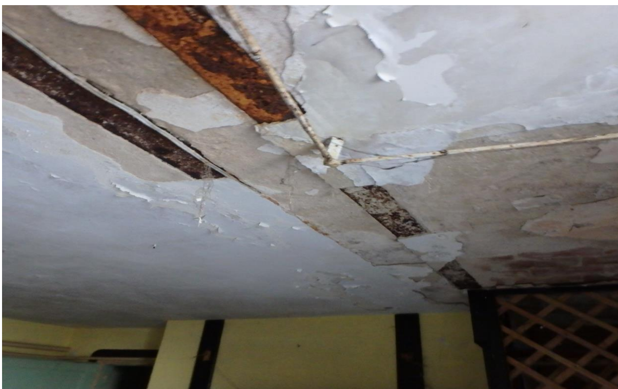
Zdjęcie nr 38 - Pomieszczenie na parterze budynku
