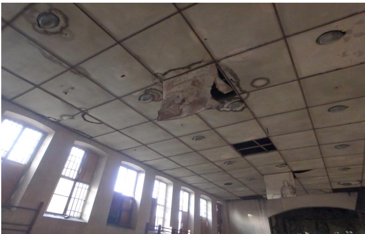
Zdjęcie nr 44 - Pomieszczenie na piętrze budynku
