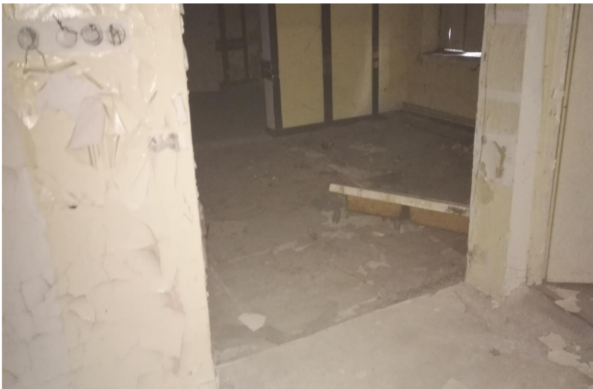
Zdjęcie nr 15 - Pomieszczenie na parterze budynku
