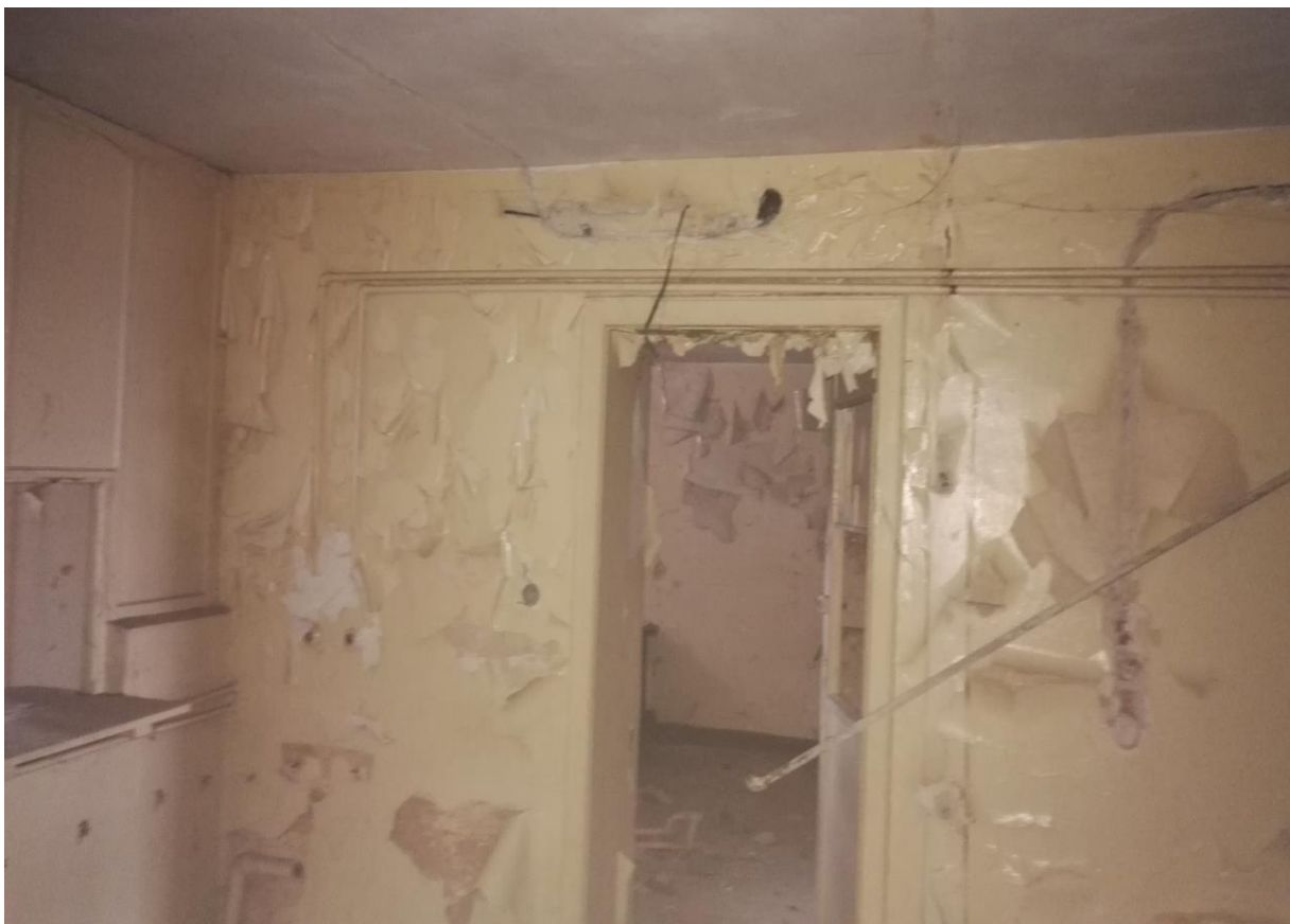
Zdjęcie nr 13 - Pomieszczenie na parterze budynku
