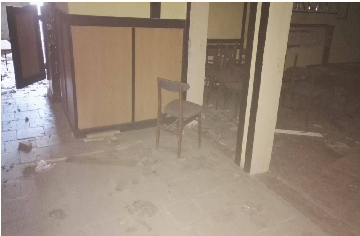
Zdjęcie nr 14 - Pomieszczenie na parterze budynku
