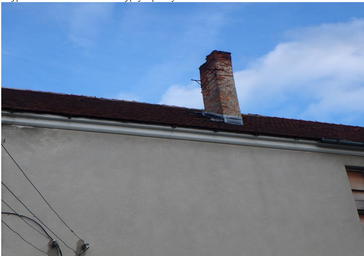
Zdjęcie nr 8 - Widok na elewację tylną budynku (zbliżenie na komin)
