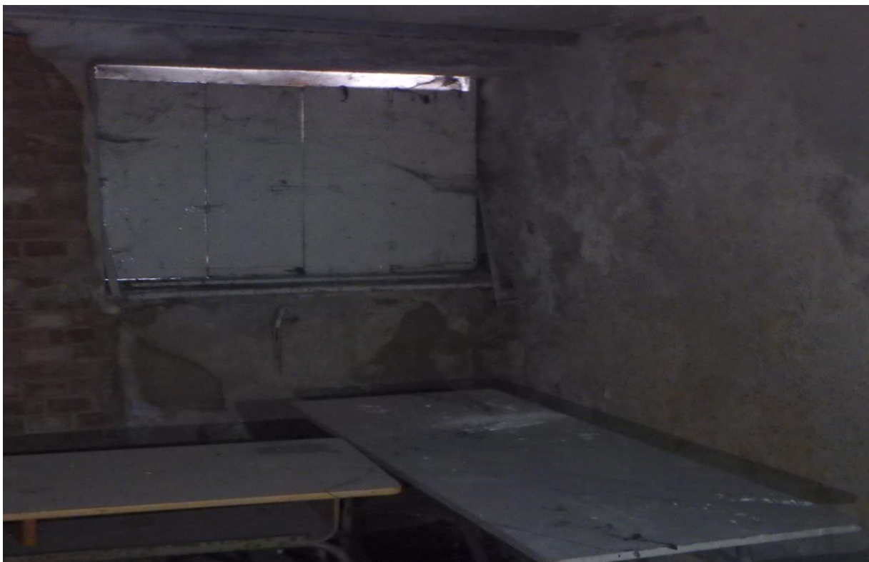
Zdjęcie nr 34 - Pomieszczenie na parterze budynku
