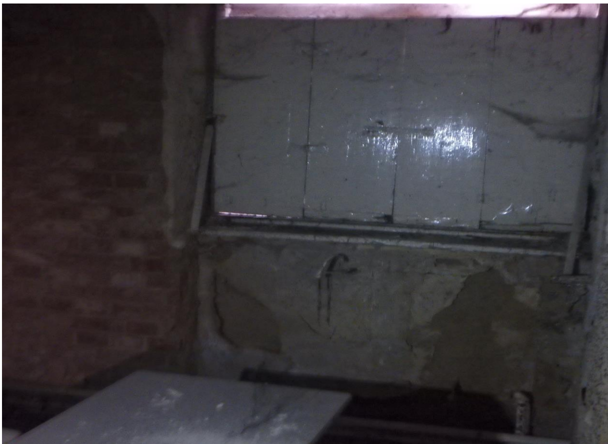
Zdjęcie nr 33 - Pomieszczenie na parterze budynku
