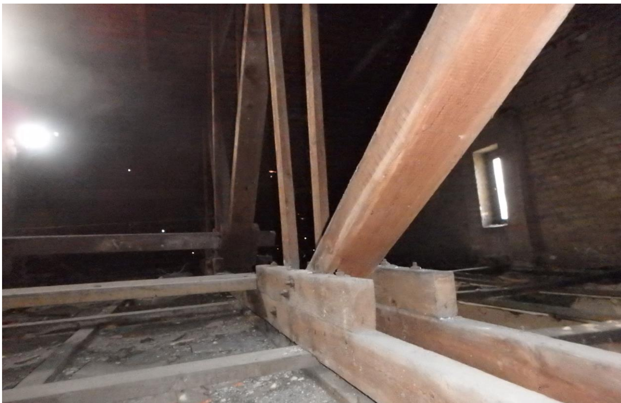
Zdjęcie nr 51 - Pomieszczenie na strychu budynku
