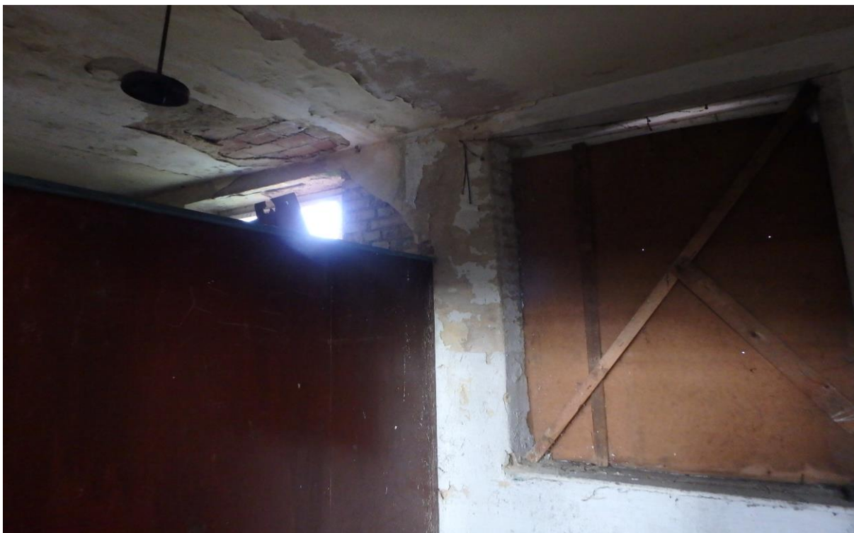
Zdjęcie nr 43 - Pomieszczenie na piętrze budynku
