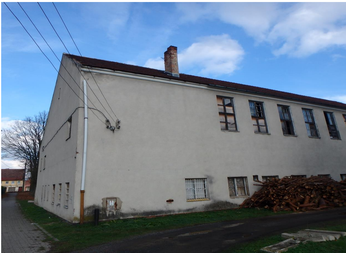
Zdjęcie nr 7 - Widok na elewację tylną budynku
