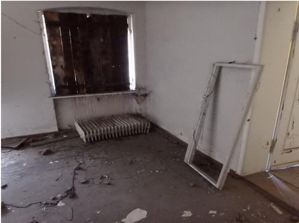
Zdjęcie nr 29 - Pomieszczenie na parterze budynku
