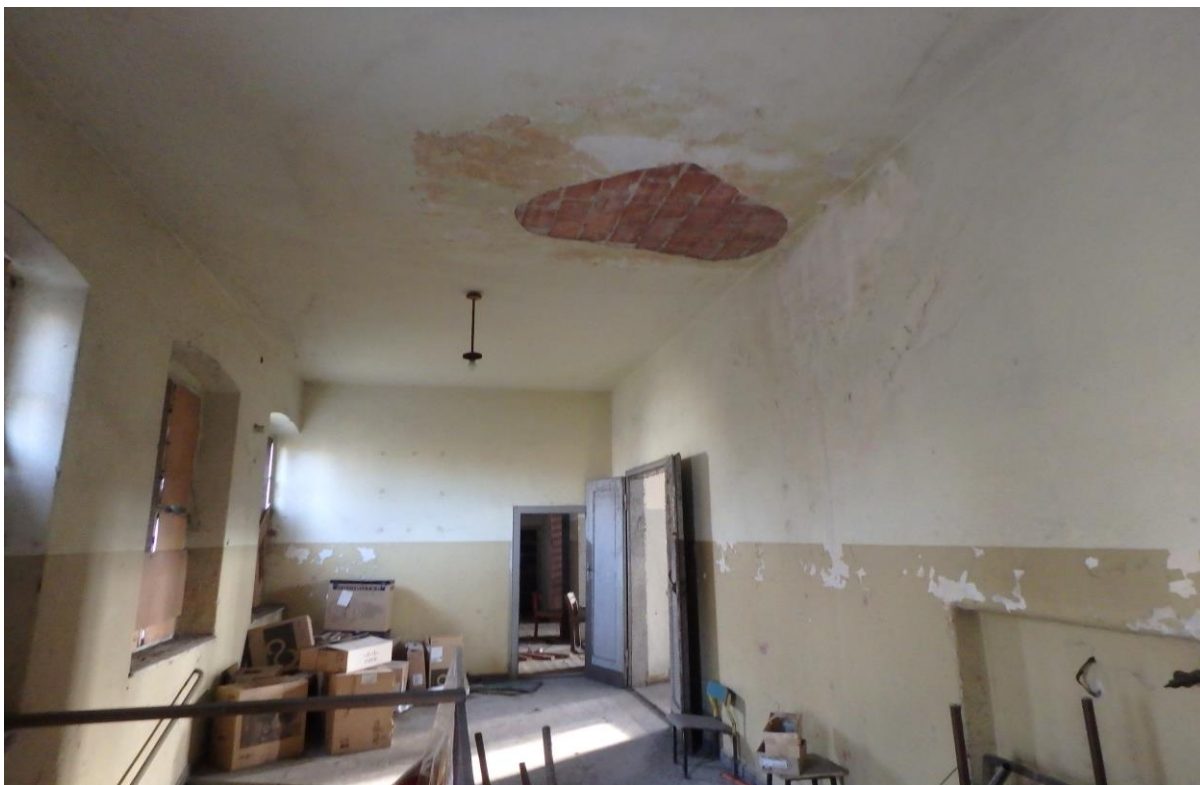
Zdjęcie nr 41 - Pomieszczenie na piętrze budynku
