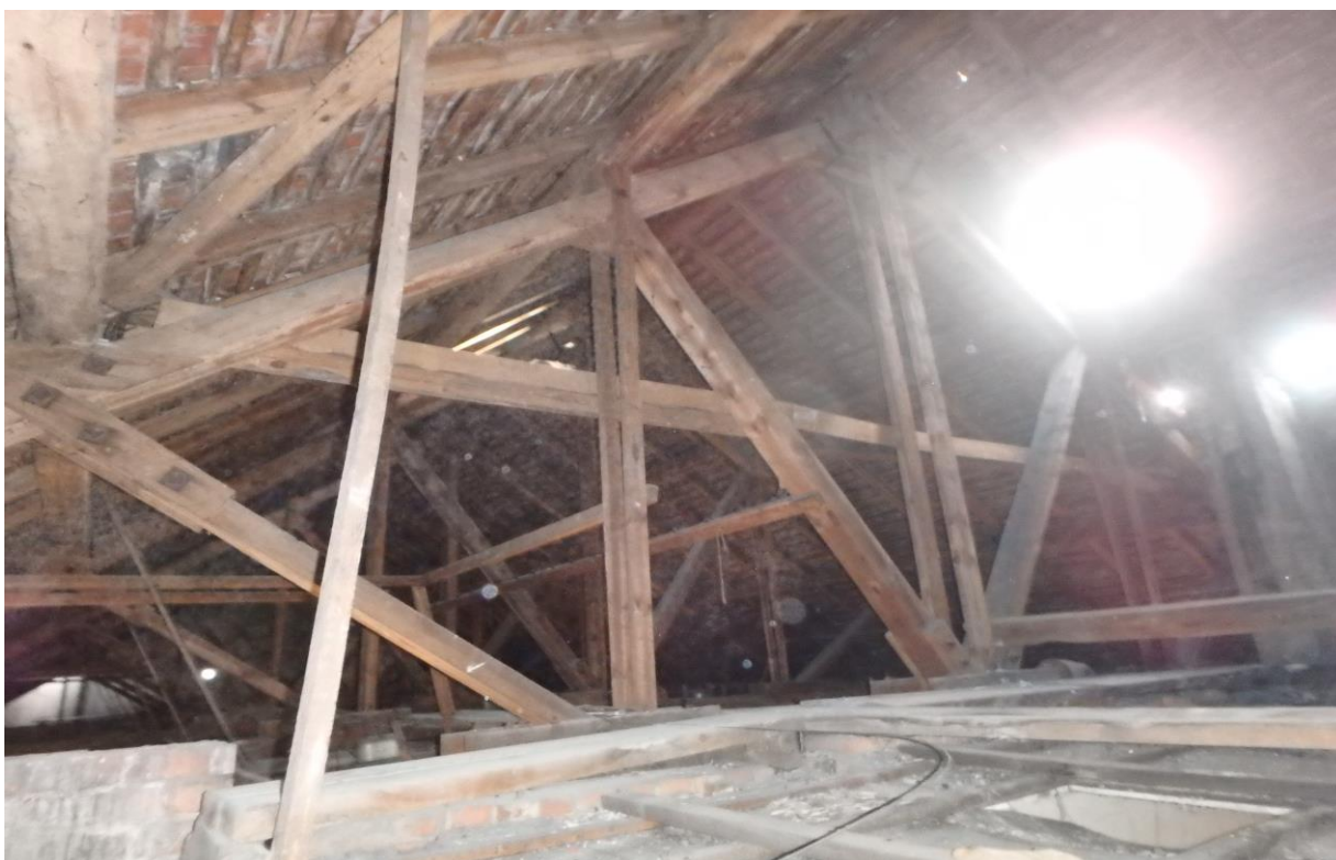
Zdjęcie nr 52 - Pomieszczenie na strychu budynku
