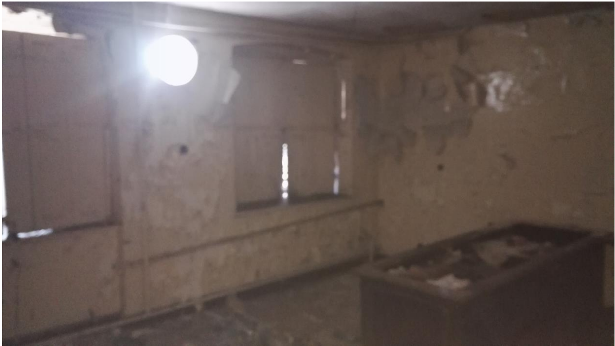
Zdjęcie nr 21 - Pomieszczenie na parterze budynku
