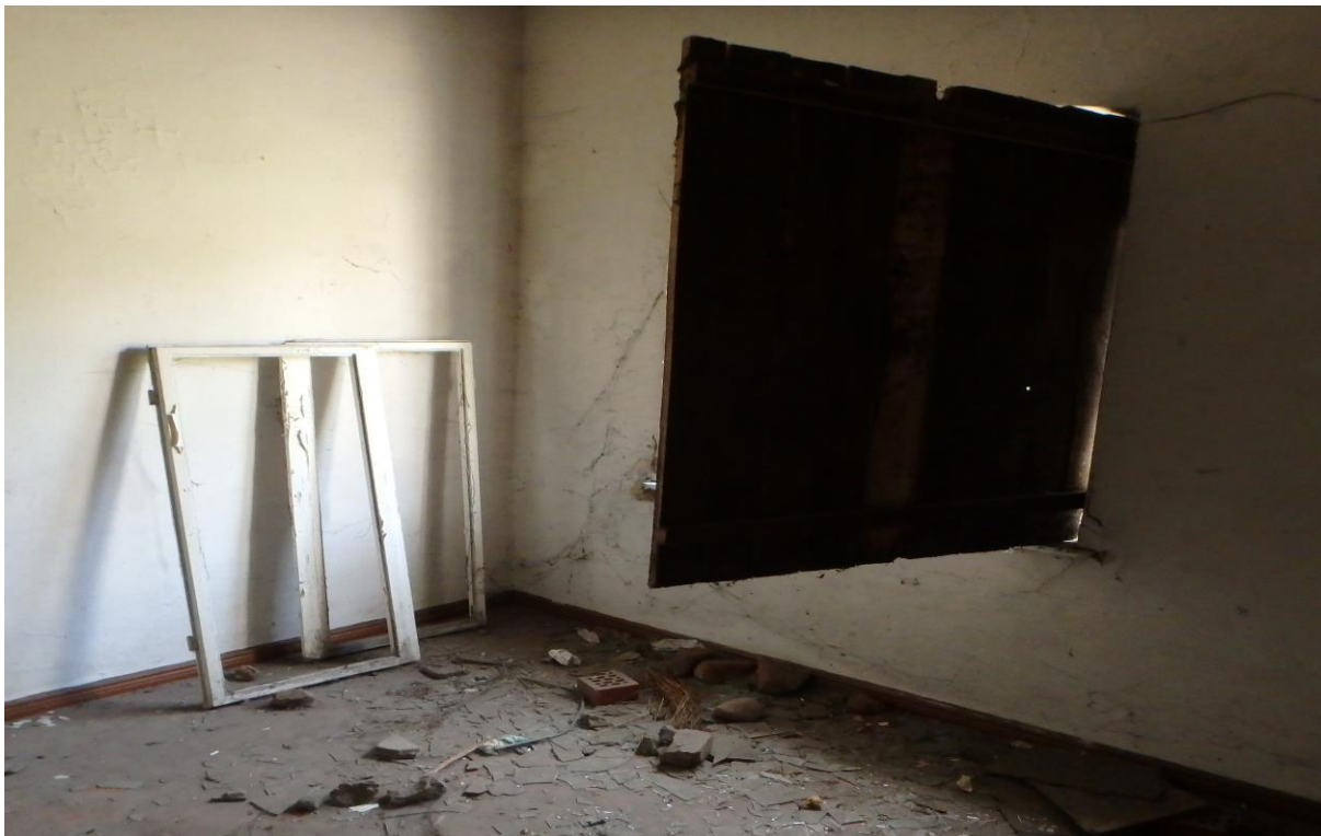
Zdjęcie nr 30 - Pomieszczenie na parterze budynku
