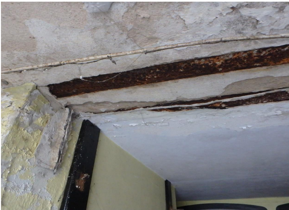
Zdjęcie nr 37 - Pomieszczenie na parterze budynku
