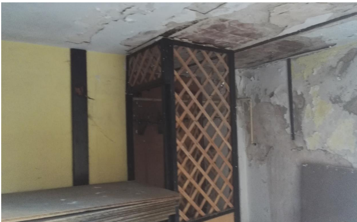
Zdjęcie nr 10 - Pomieszczenie na parterze budynku
