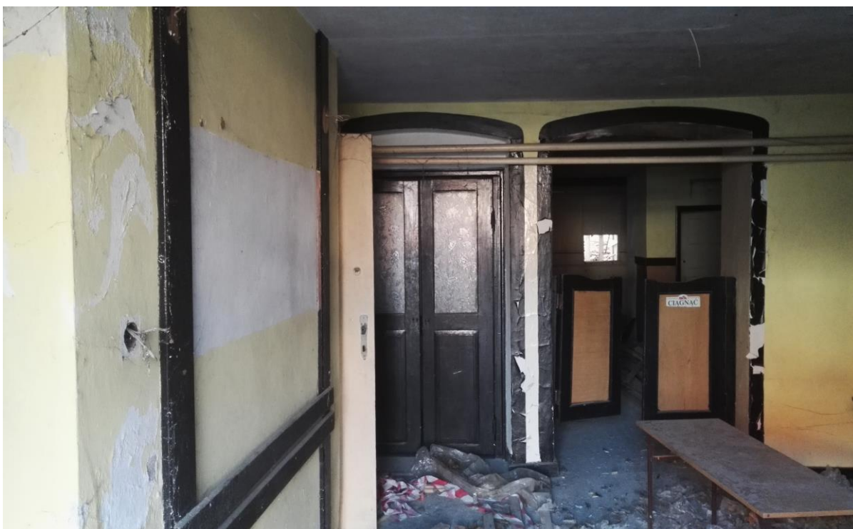
Zdjęcie nr 12 - Pomieszczenia na parterze budynku
