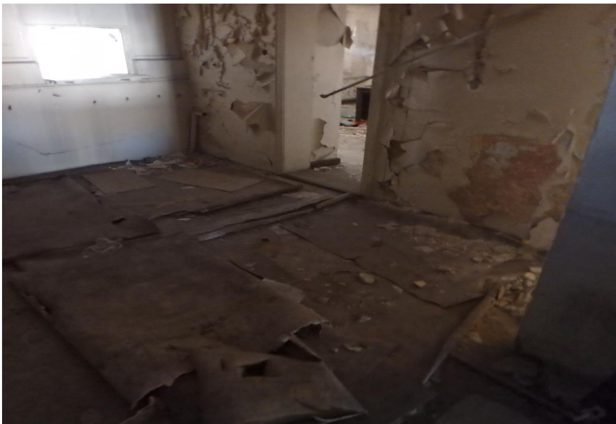
Zdjęcie nr 25 - Pomieszczenie na parterze budynku
