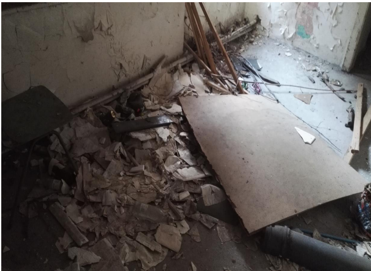
Zdjęcie nr 19 - Pomieszczenie na parterze budynku
