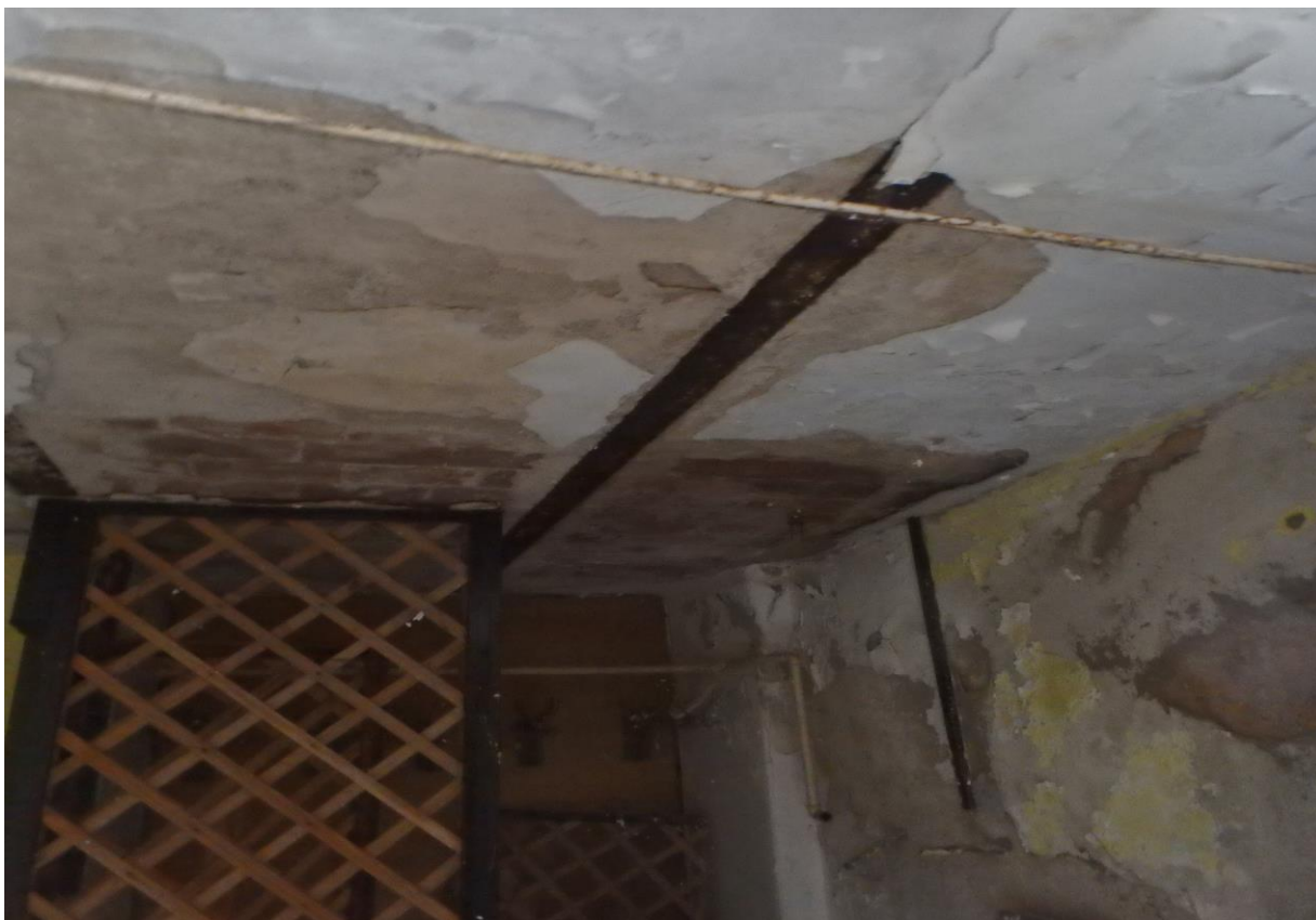
Zdjęcie nr 23 - Pomieszczenie na parterze budynku
