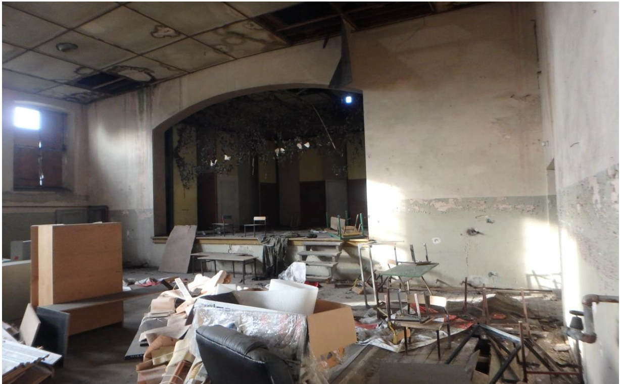
Zdjęcie nr 45 - Pomieszczenie na piętrze budynku
