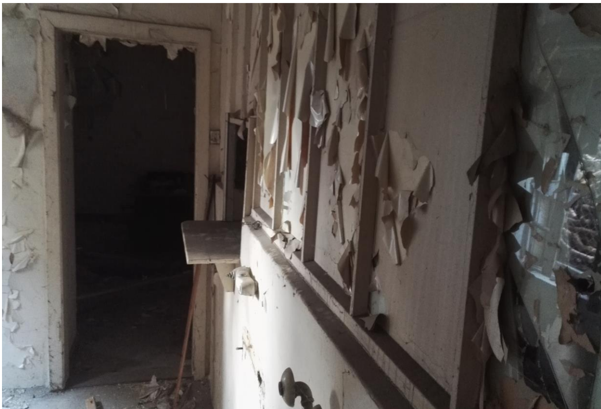
Zdjęcie nr 20 - Pomieszczenie na parterze budynku
