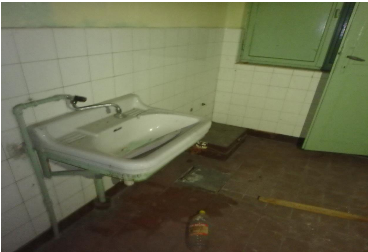
Zdjęcie nr 39 - Pomieszczenie na parterze budynku
