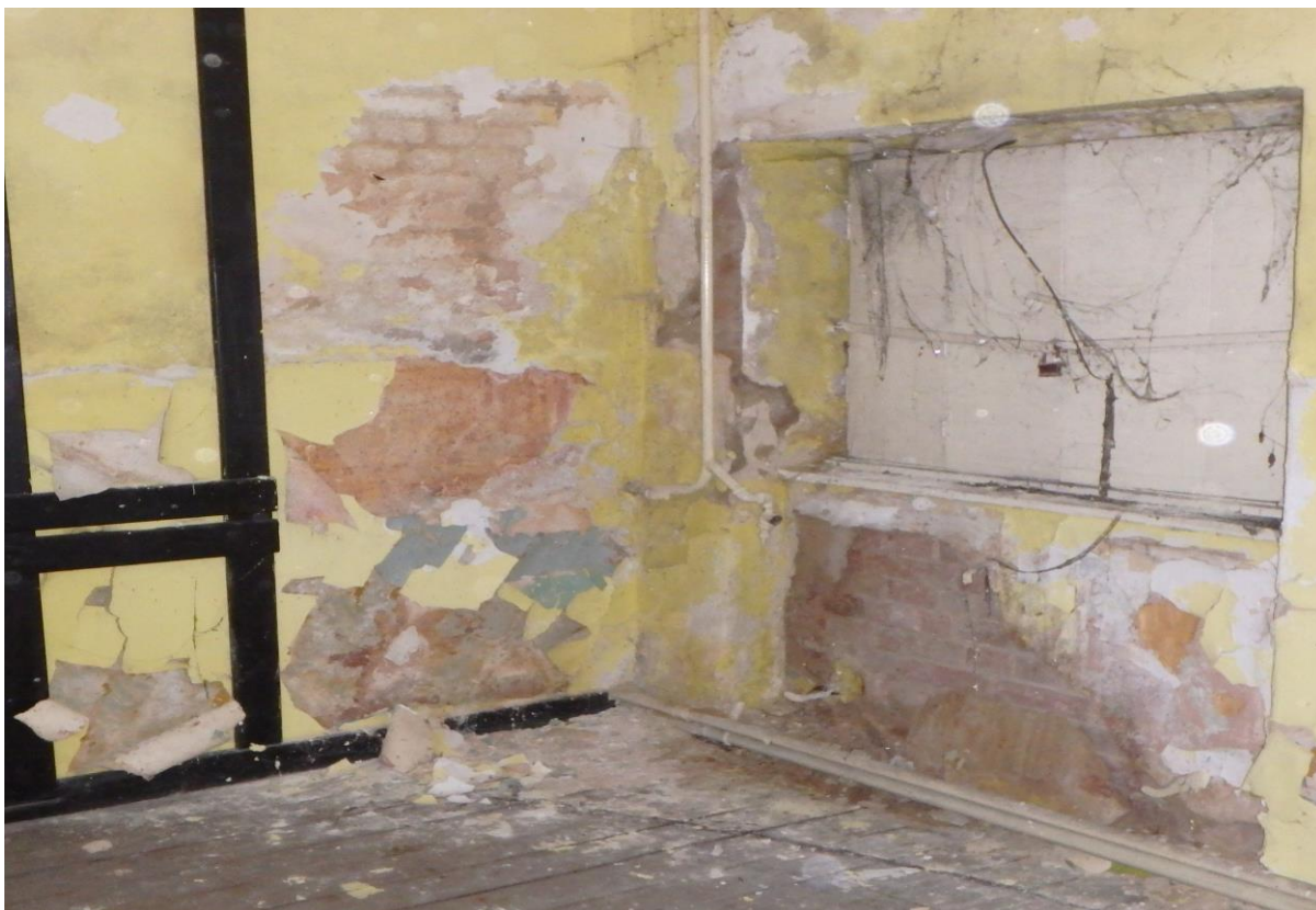
Zdjęcie nr 31 - Pomieszczenie na parterze budynku
