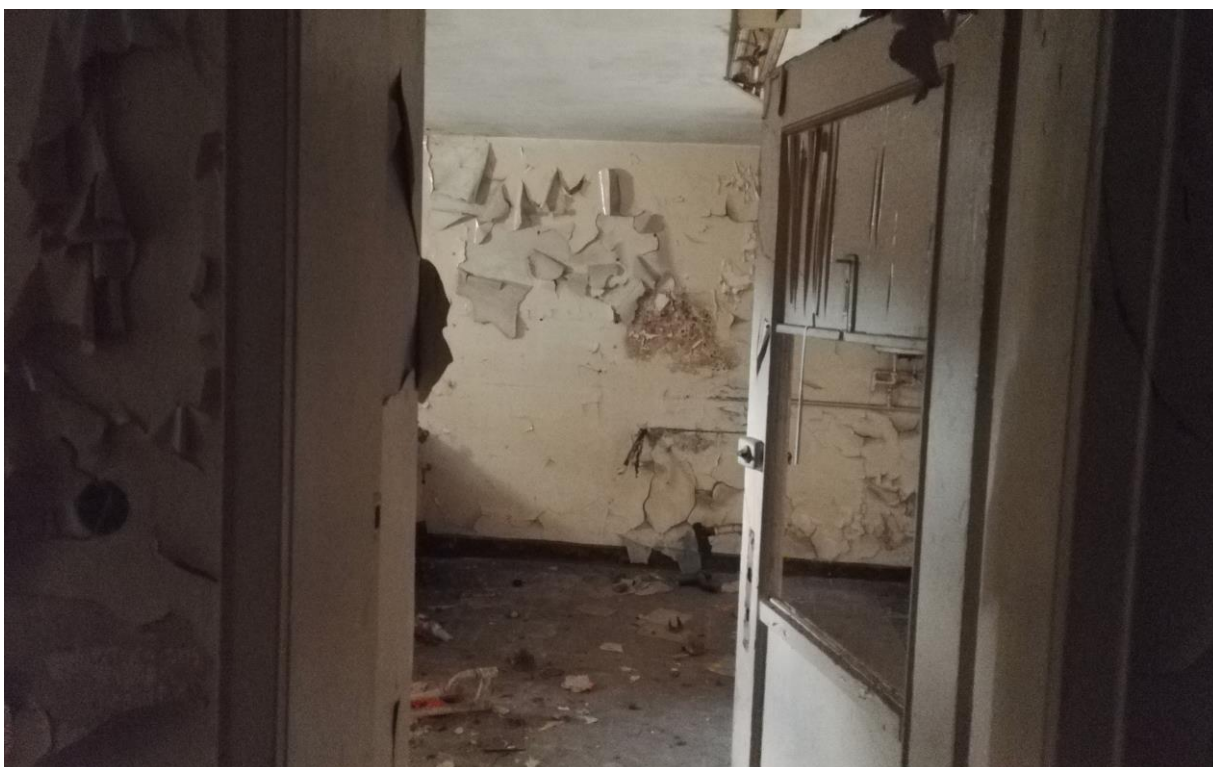
Zdjęcie nr 16 - Pomieszczenie na parterze budynku
