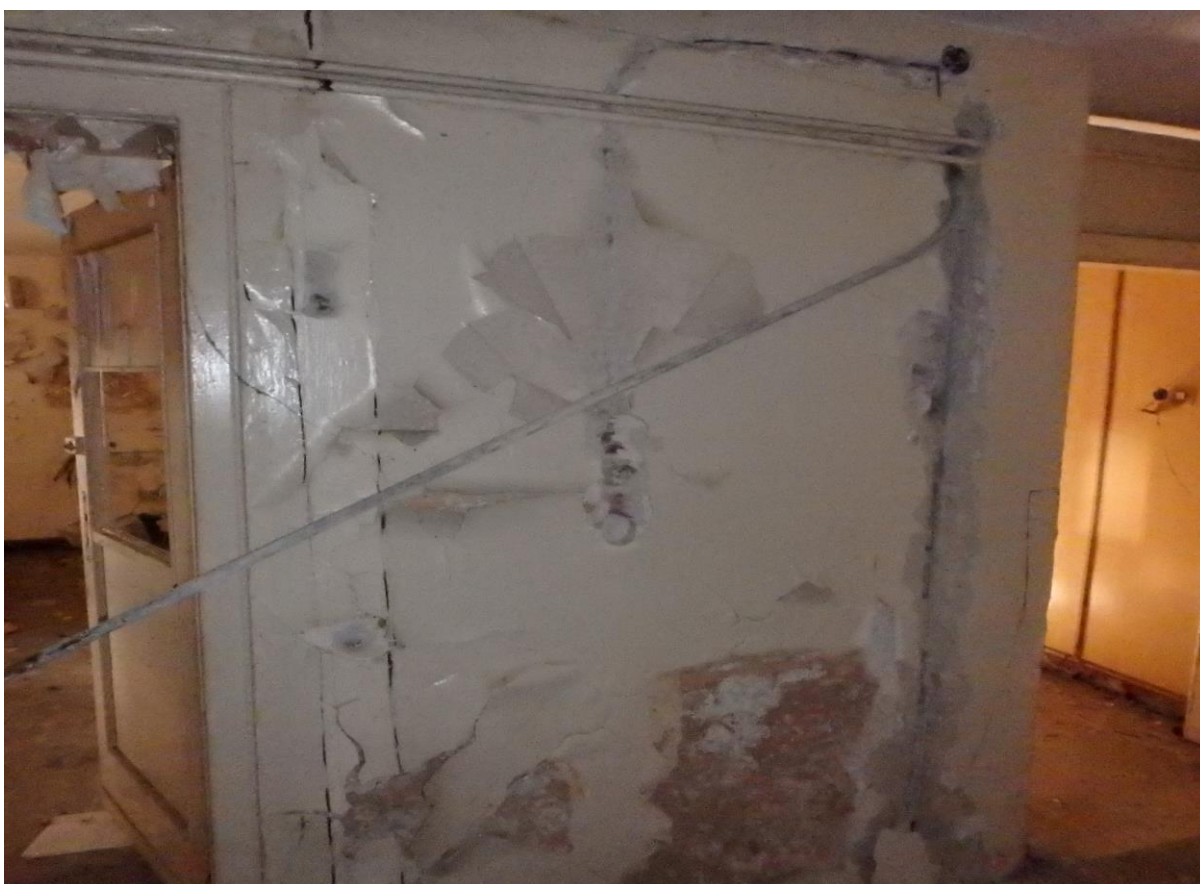
Zdjęcie nr 28 - Pomieszczenie na parterze budynku
