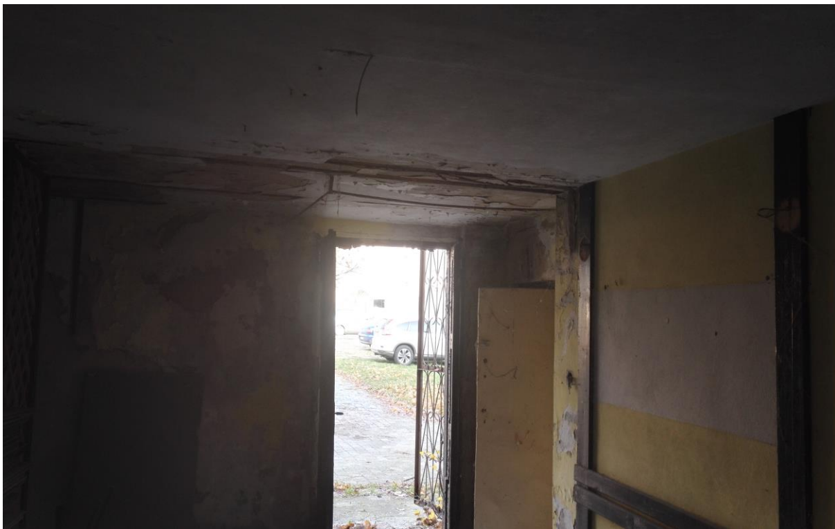
Zdjęcie nr 9 - Pomieszczenie na parterze budynku
