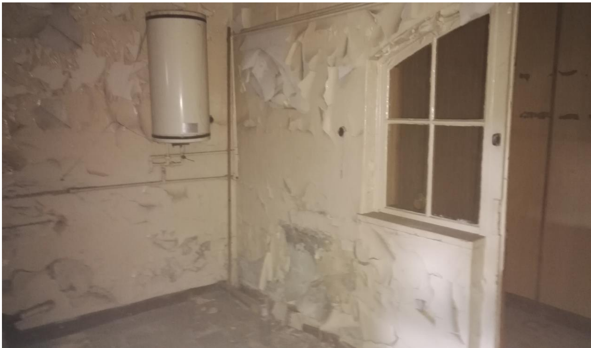
Zdjęcie nr 22 - Pomieszczenie na parterze budynku
