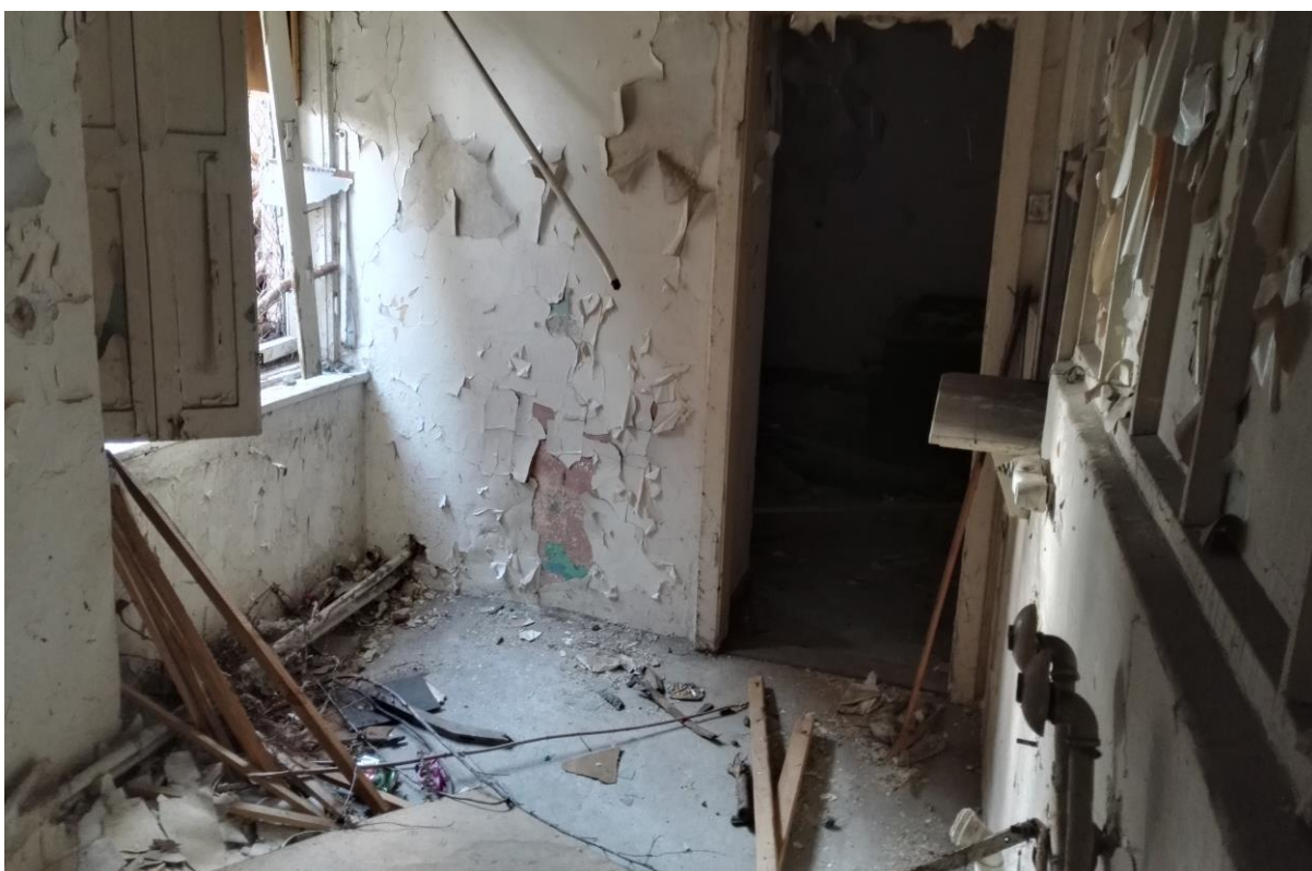
Zdjęcie nr 18 - Pomieszczenie na parterze budynku
