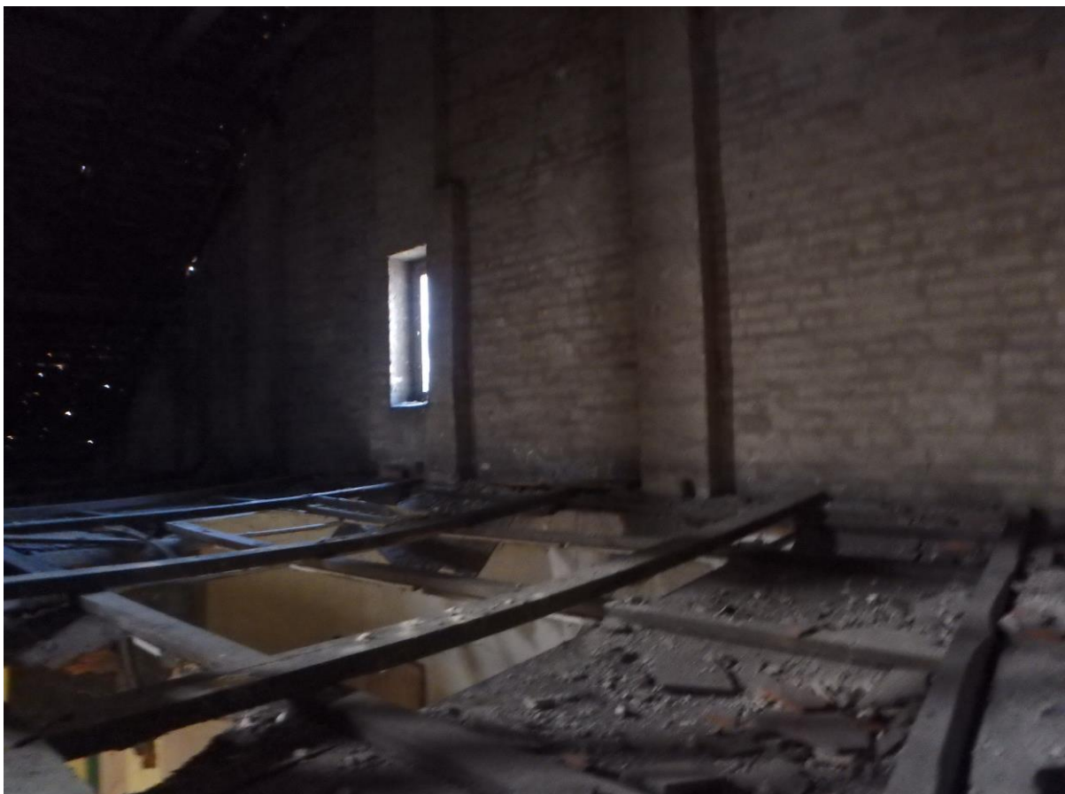
Zdjęcie nr 53 - Pomieszczenie na strychu budynku
