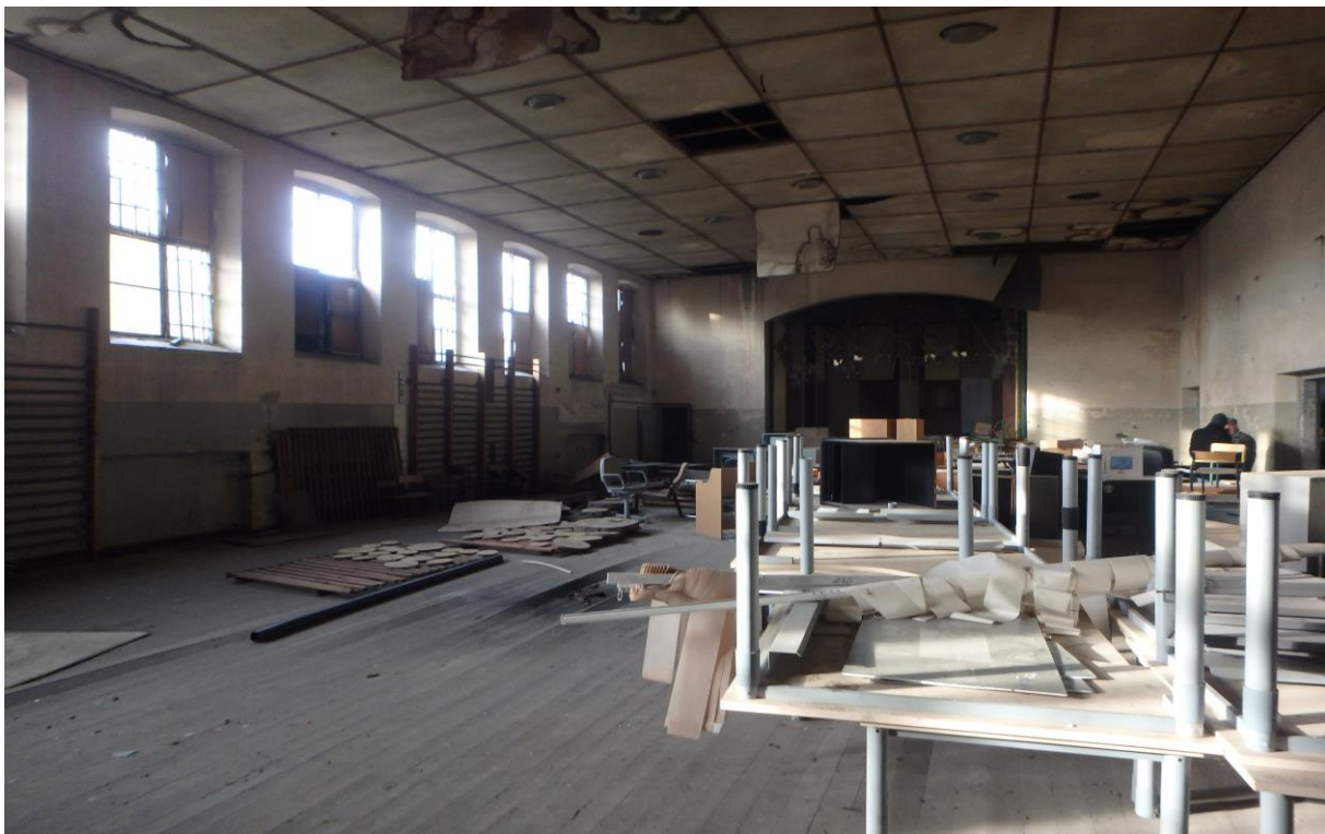
Zdjęcie nr 48 - Pomieszczenie na piętrze budynku
