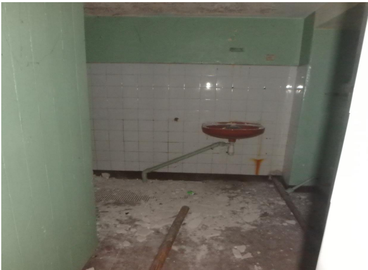
Zdjęcie nr 35 - Pomieszczenie na parterze budynku
