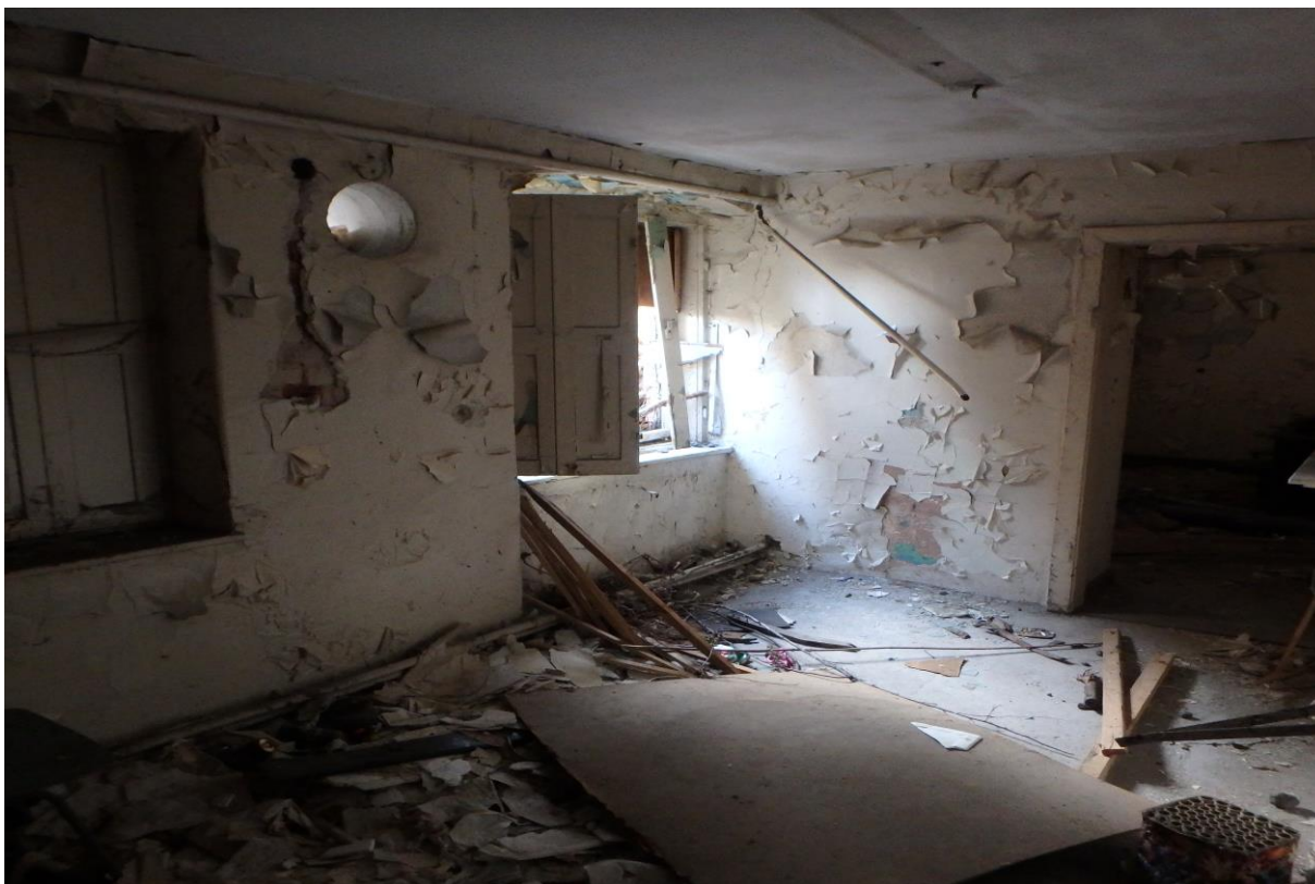
Zdjęcie nr 27 - Pomieszczenie na parterze budynku
