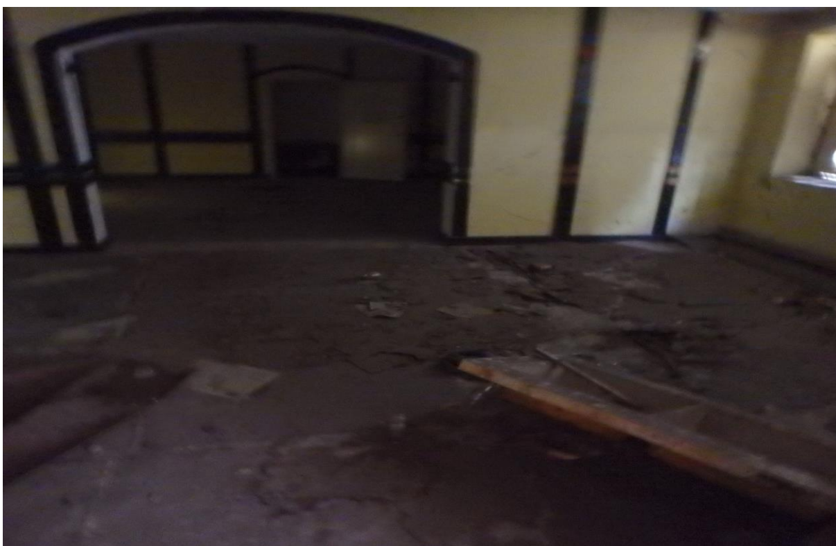
Zdjęcie nr 26 - Pomieszczenie na parterze budynku
