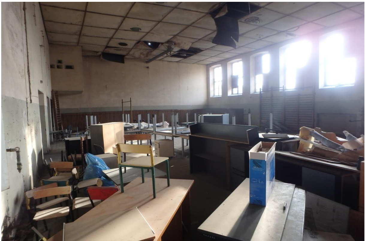
Zdjęcie nr 46 - Pomieszczenie na piętrze budynku
