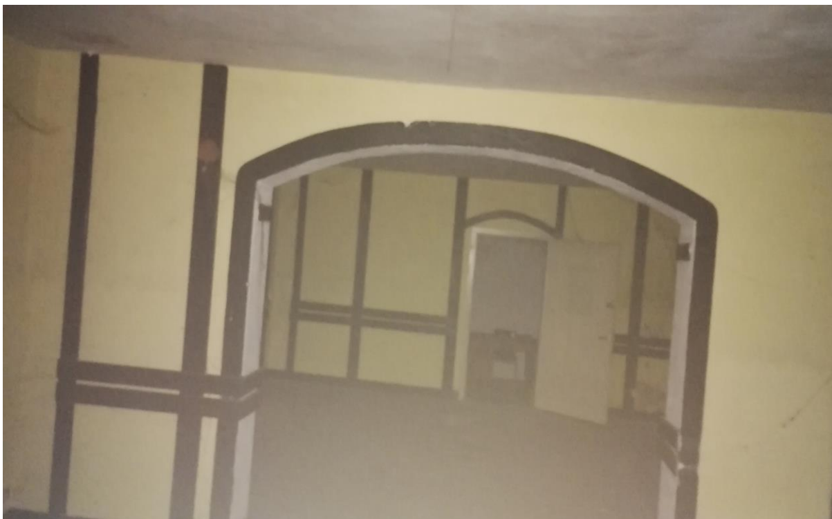
Zdjęcie nr 17 - Pomieszczenie na parterze budynku
