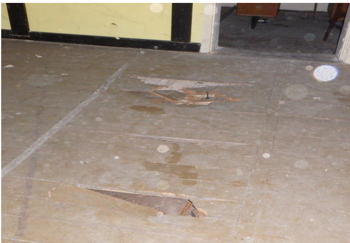
Zdjęcie nr 32 - Pomieszczenie na parterze budynku
