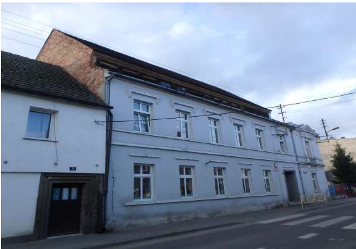
Zdjęcie nr 9 – Widok na elewację frontową budynku
