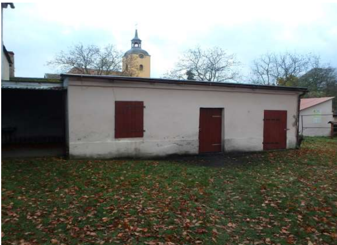
Zdjęcie nr 14 – Widok na elewację tylną budynku (budynek gospodarczy)
