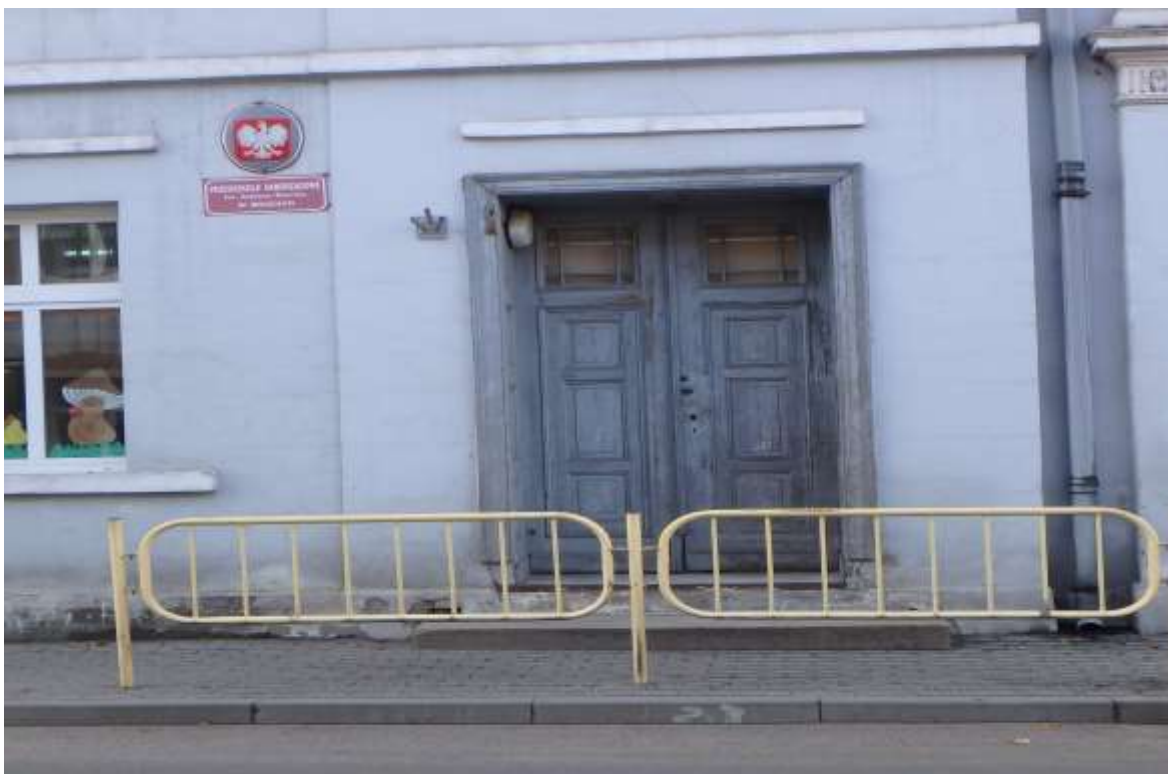
Zdjęcie nr 7 – Widok na elewację frontową budynku (zbliżenie na wejście główne)
