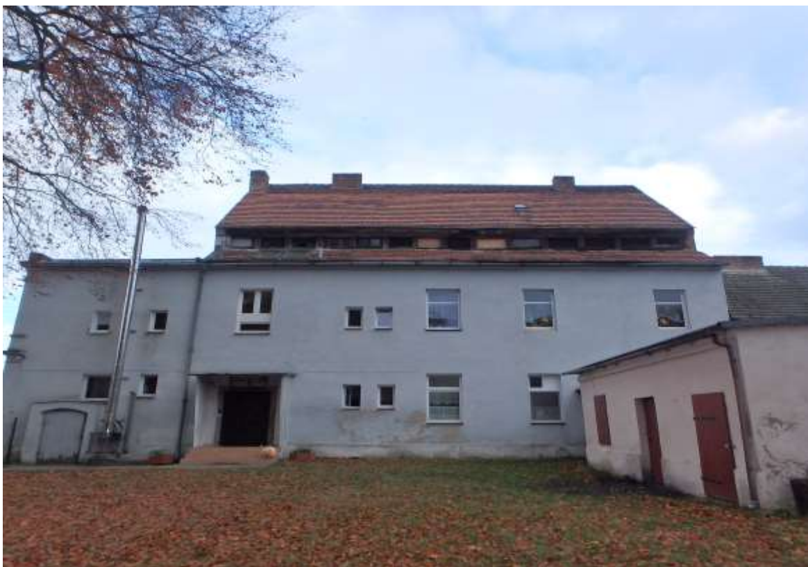
Zdjęcie nr 13 – Widok na elewację tylną budynku
