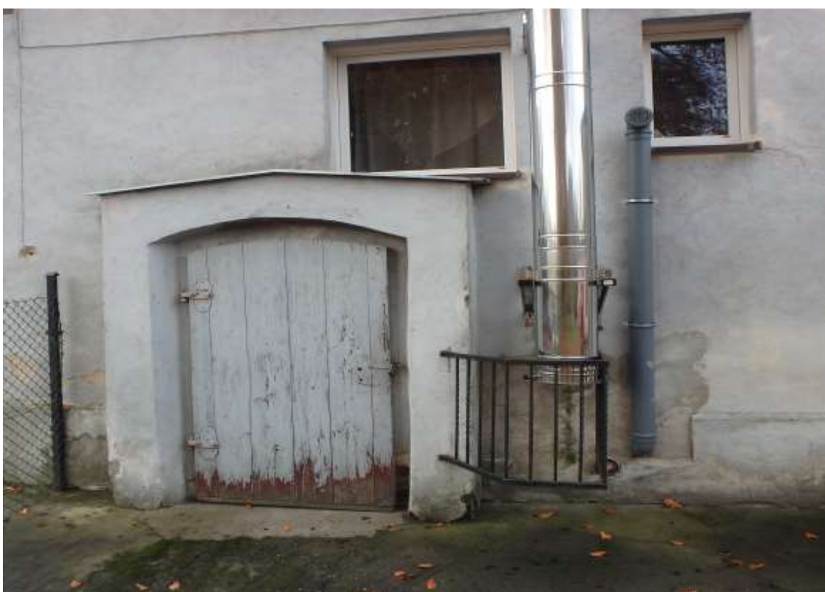
Zdjęcie nr 12 – Widok na elewację tylną budynku
