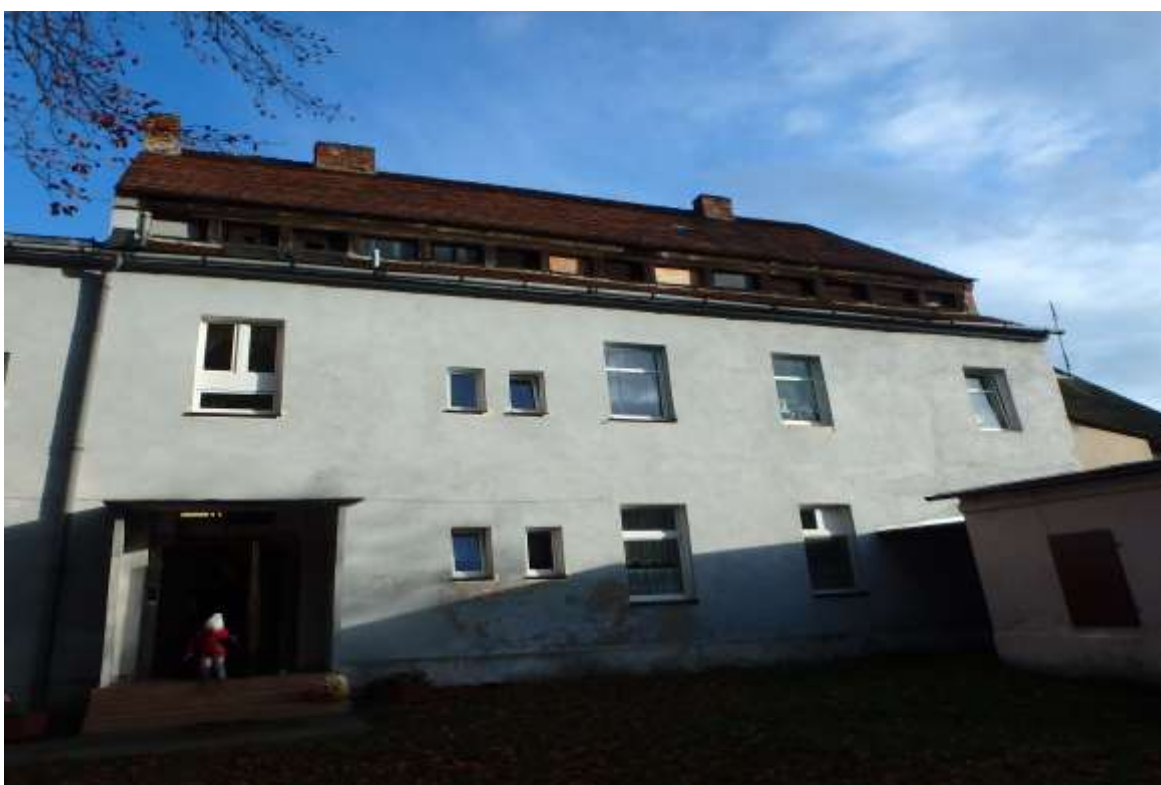
Zdjęcie nr 10 – Widok na elewację tylną budynku
