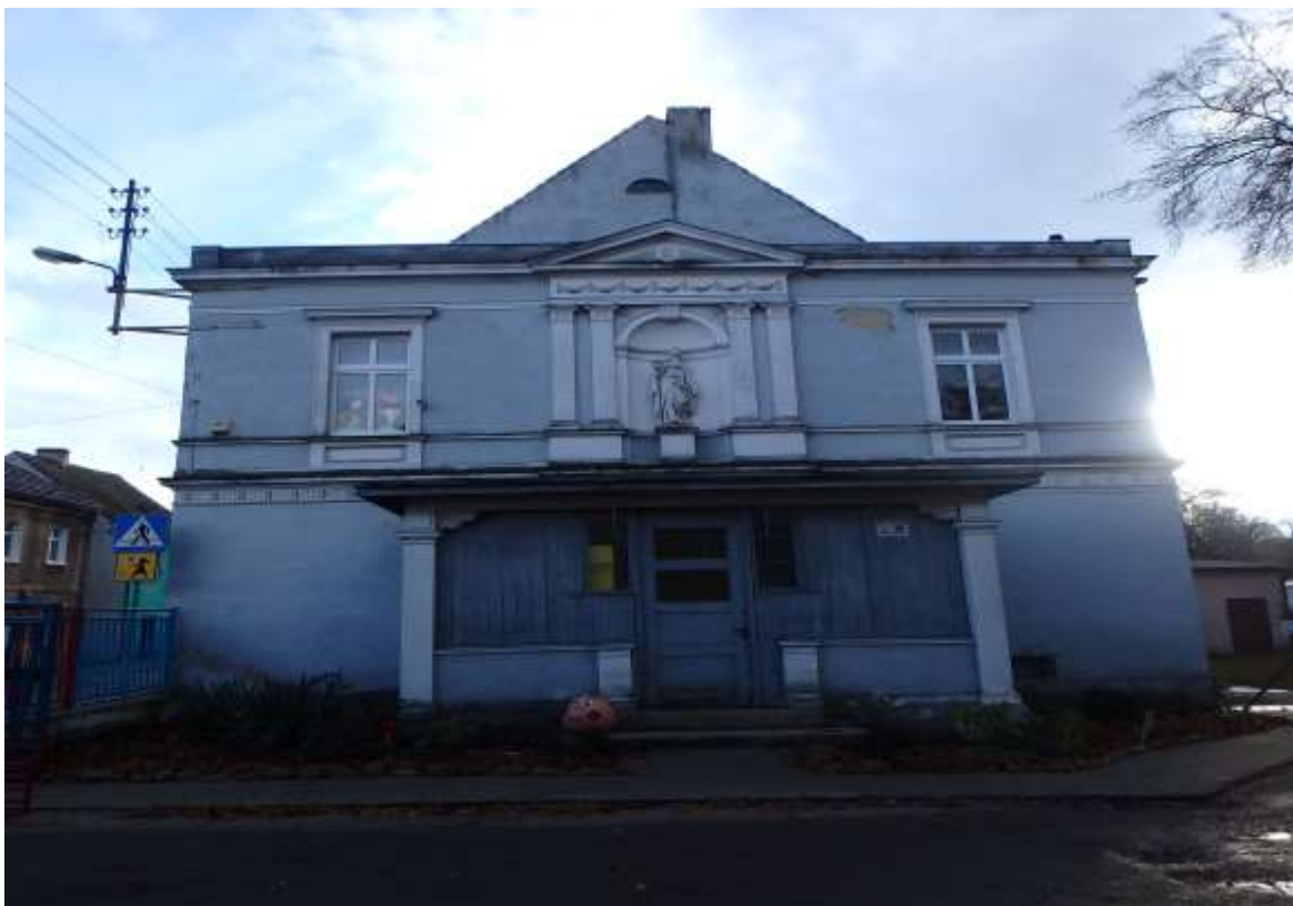
Zdjęcie nr 1 – Widok na elewację boczną budynku
