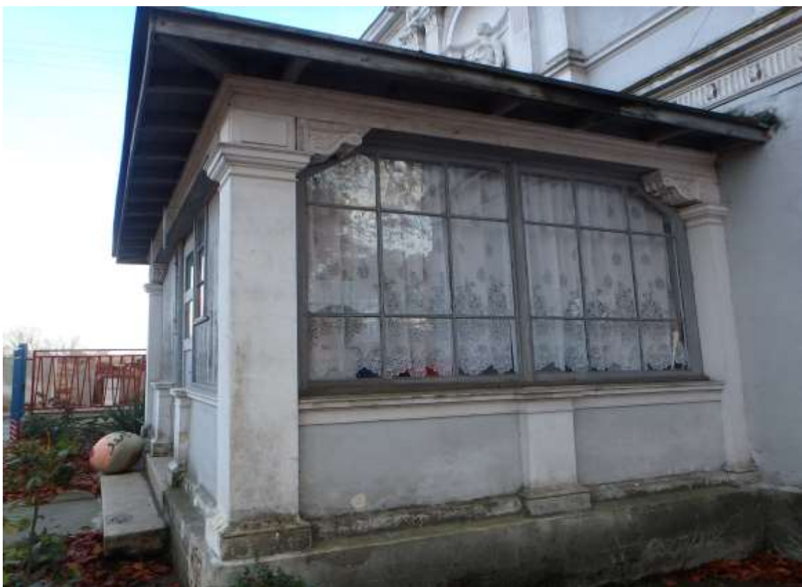
Zdjęcie nr 2 – Widok na zespół wejściowy na elewacji bocznej budynku
