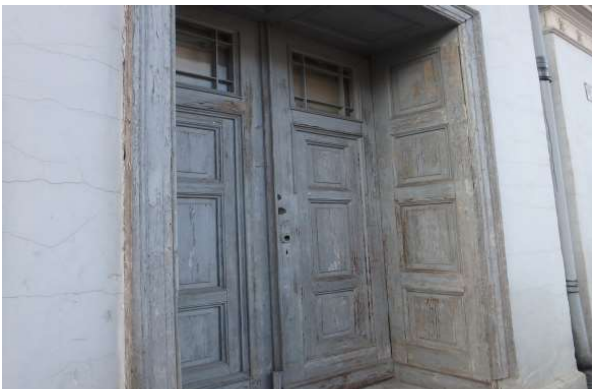
Zdjęcie nr 8 – Widok na elewację frontową budynku (zbliżenie na wejście główne)
