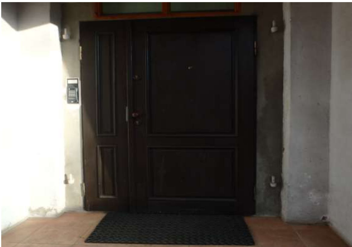
Zdjęcie nr 11 – Widok na elewację tylną budynku (drzwi wejściowe)
