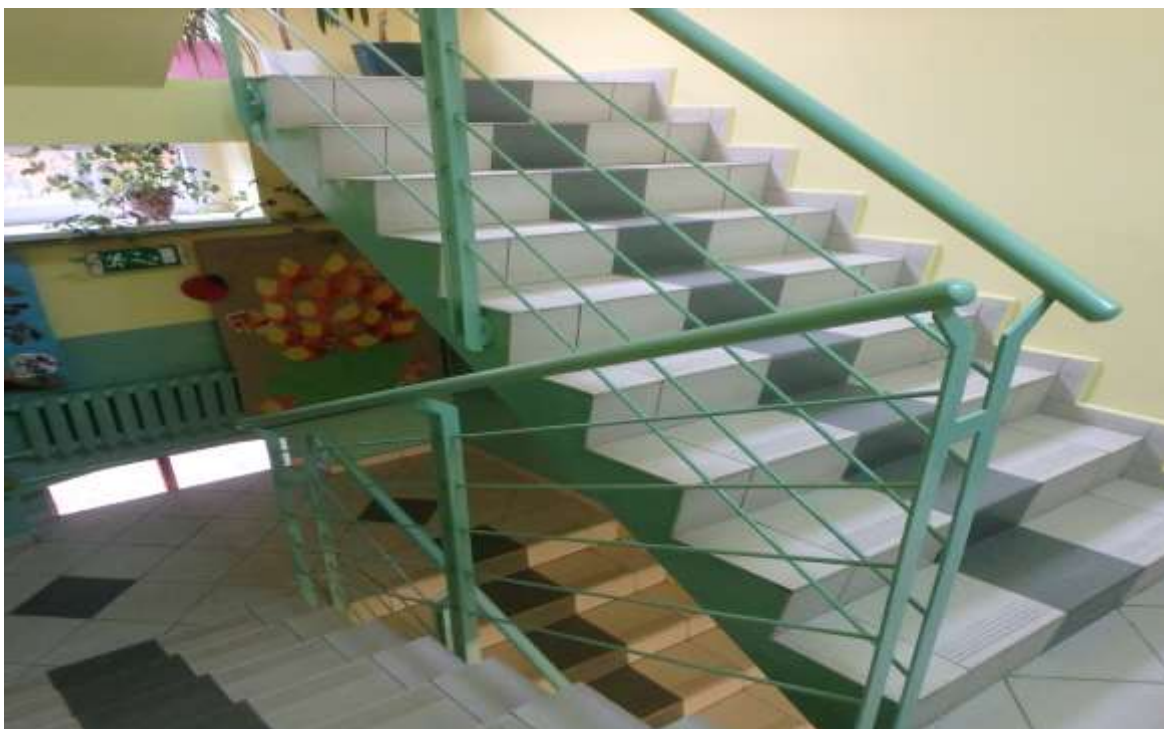
Zdjęcie nr 25 – Klatka schodowa
