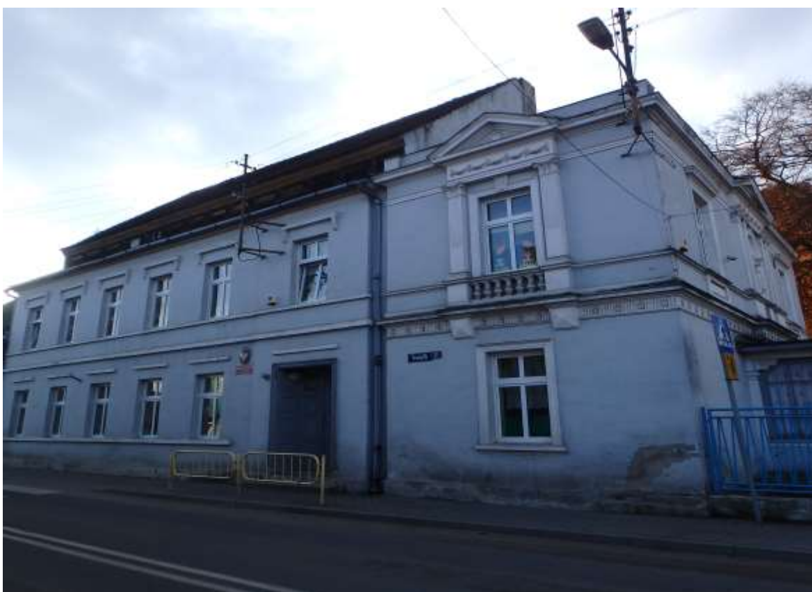
Zdjęcie nr 6 – Widok na elewację frontową budynku
