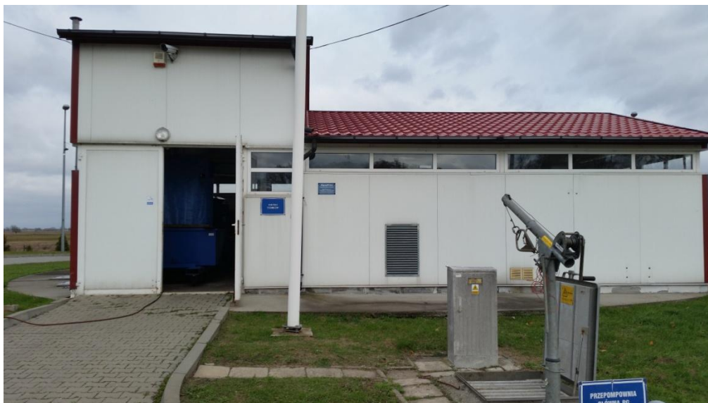
Rysunek 18. Widok na oczyszczalnię ścieków w Jeziorach Dolnych
